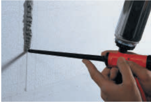
Abb. 47: Das Ausschäumen mit Fugenschäum bei Fugenbreiten ist bis 5 mm zulässig.
