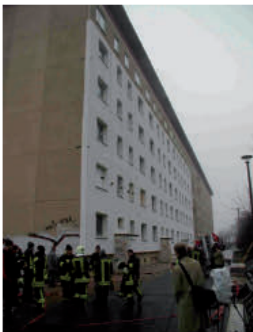
Abb. B5: Das Versuchsgebäude von 2006: sechsgeschossiges, zum Abriss bestimmtes Wohnhaus in Plattenbauweise mit Waschbetonfassade.
